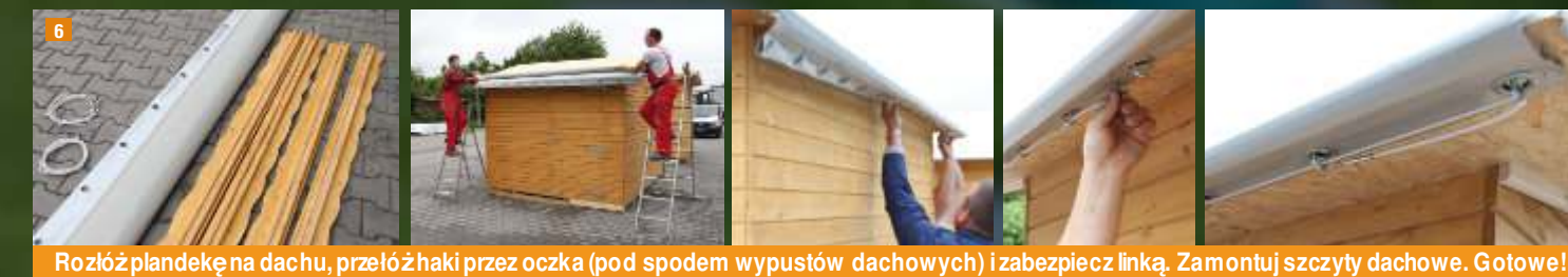
Rozłóż plandekę na dachu, przełóż haki przez oczka (pod spodem wypustów dachowych) i zabezpiecz linką. Zamontuj szczyty dachowe. Gotowe!
