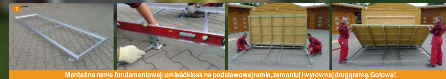
Montaż na ramie fundamentowej: umieść kiosk na podstawowej ramie, zamontuj i wyrównaj drugą ramę. Gotowe!
